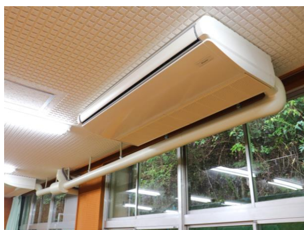
上山路小学校特別教室空調設置工事
