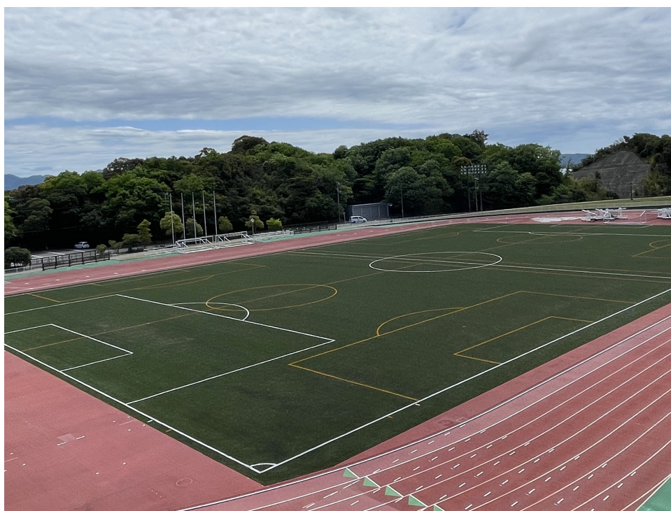
田辺スポーツパーク陸上競技場改修
