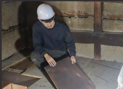
▼天井の板を外す様子。「立派な木は“生け捕り”にできる」と、外した板の再利用の方法を探します。
