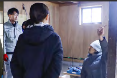
▼天井の板を外す様子。「立派な木は“生け捕り”にできる」と、外した板の再利用の方法を探します。
