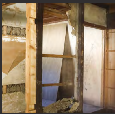
▲▼壁を抜いたり、板をはがしたりする作業を、専門職の方がレクチャーしながら、みんなで行う。
