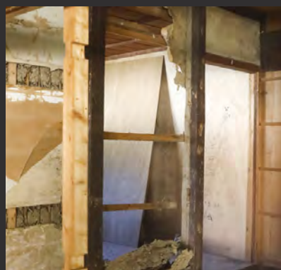
▲▼壁を抜いたり、板をはがしたりする作業を、専門職の方がレクチャーしながら、みんなで行う。
