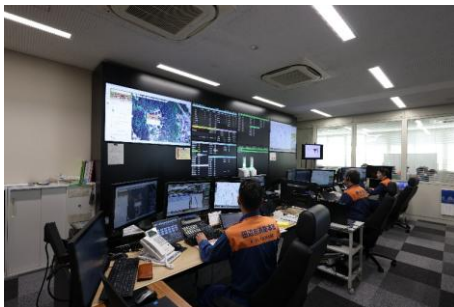
消防通信指令システム整備事業
