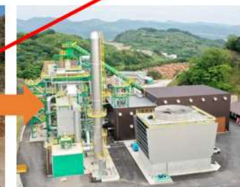
木質バイオマス発電所
