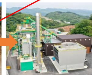
木質バイオマス発電所
