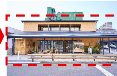
整備後の交流拠点
