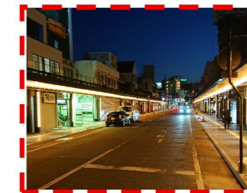
整備後の夜の駅前商店街
