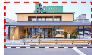
整備後の交流拠点
