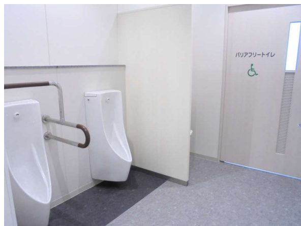
新庄第二小学校トイレ改修・ バリアフリー化工事
