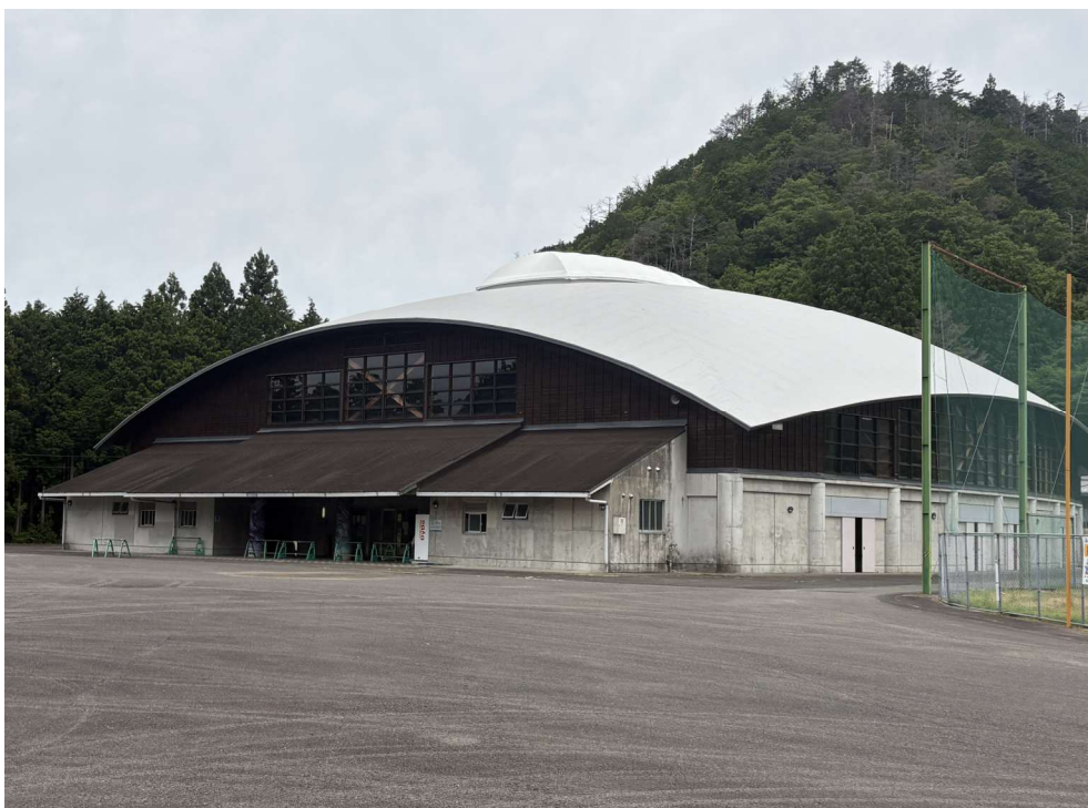
田辺市多目的運動施設（龍神ドーム）屋根改修
