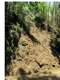
【土砂崩れの様子】
