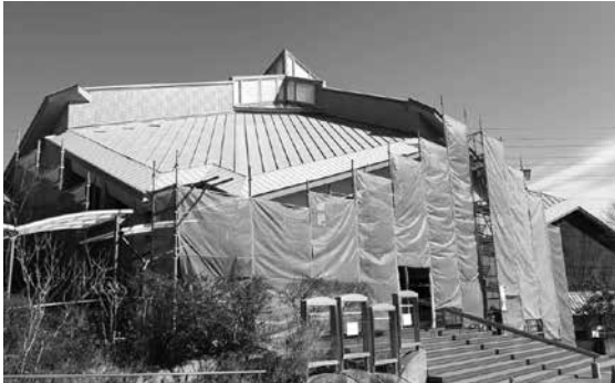
玄関周りの塗装等を行いました
