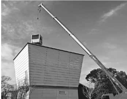
古い機械をクレーンを使って取り出しました
