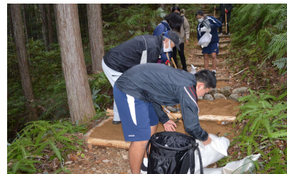
土を補充している作業の様子
