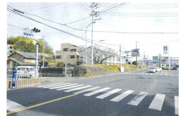
橋谷交差点付近 写真中央から右奥が防潮堤
