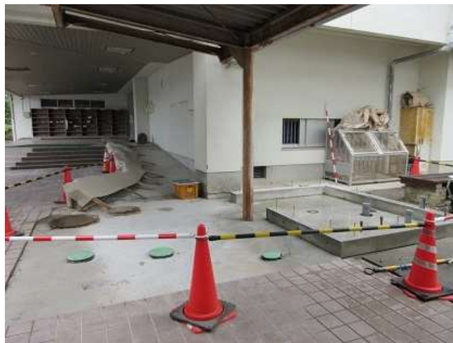
※体育館トイレ及び体育館前スロープ改修中
