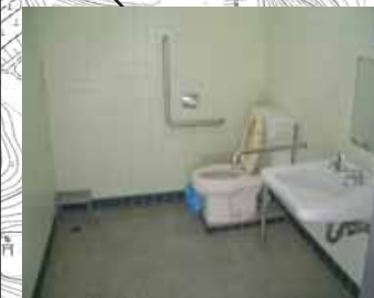
↑ 車いす使用者用便所 駅構外便所
