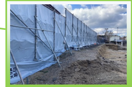
仮囲い据付状況
