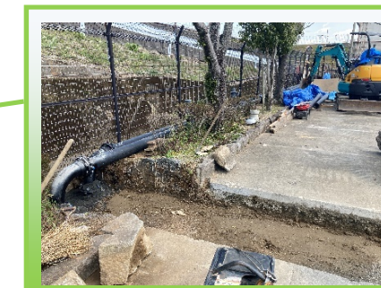
仮設配管状況
