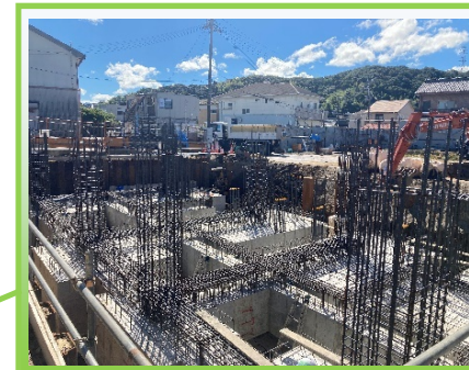
フーチング基礎打設状況
