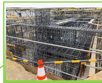
基礎部鉄筋状況
