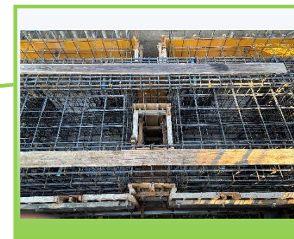
基礎部鉄筋状況
