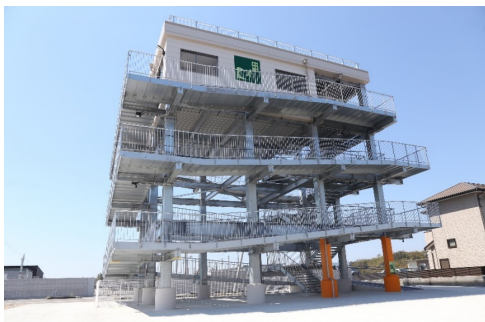
芳養地区津波避難タワー整備事業
