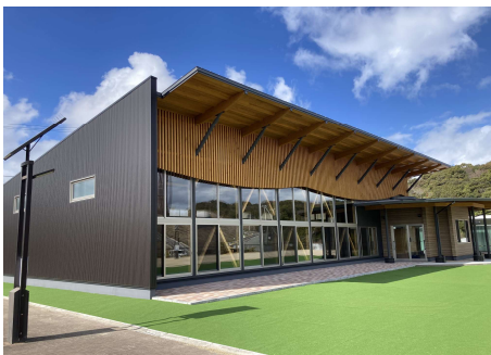
田辺スポーツパークトレーニング施設整備事業
