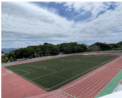
田辺スポーツパーク陸上競技場改修事業
